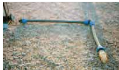
Montagem da tubagem de sucção
